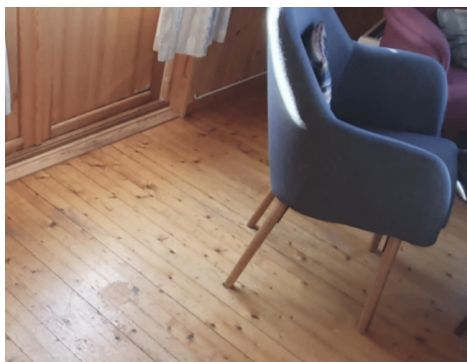
Fuktighet i dørblad i nedre del av dørblad.
