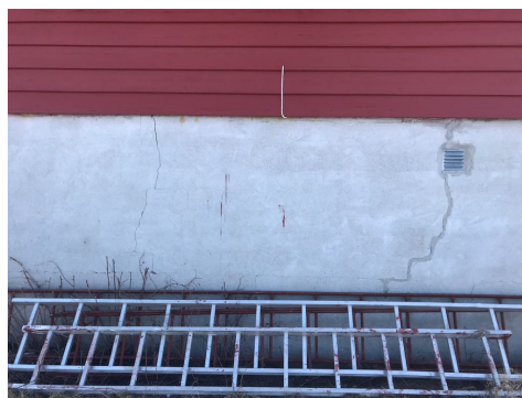
Diverse riss/sprekker i mu
