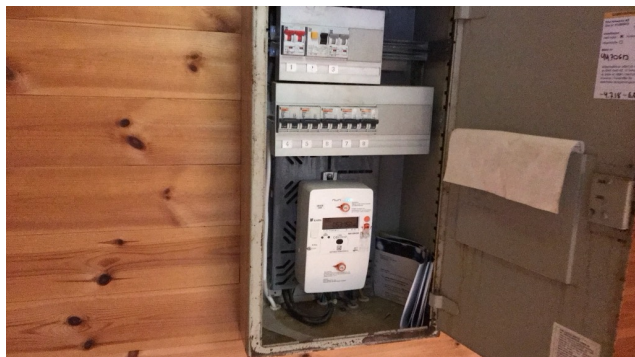
Sikringsskap/inntakssikring på loft.
