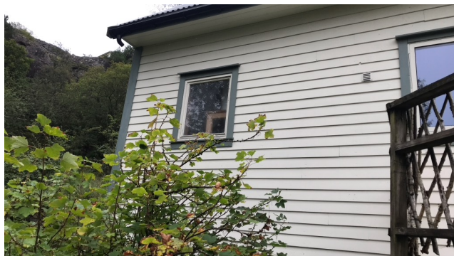
Punkttert vindu på bad.
