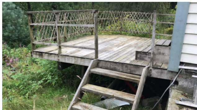
Tretrapp fra terrasse.
