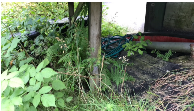
Underdimensjonert fundament.
