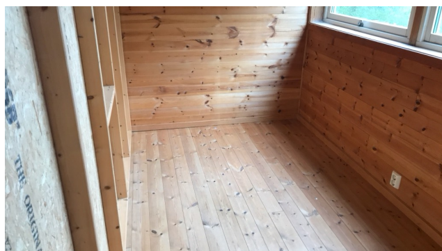
Det mangler panel/plater på skillevegg på loft.
