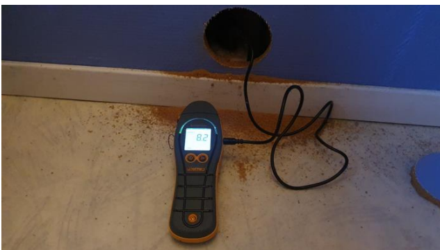
Hulltaking ble foretatt på toalett-rom, unormale avvik ble ikke påvist.
