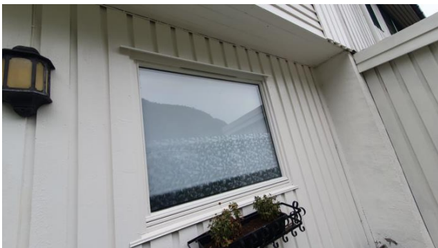
Vinduer med 2-lags isolerglass i trekarmen.
