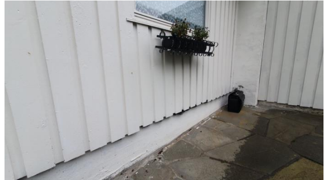
Det er ettermontert musebørste på inngangsside.
