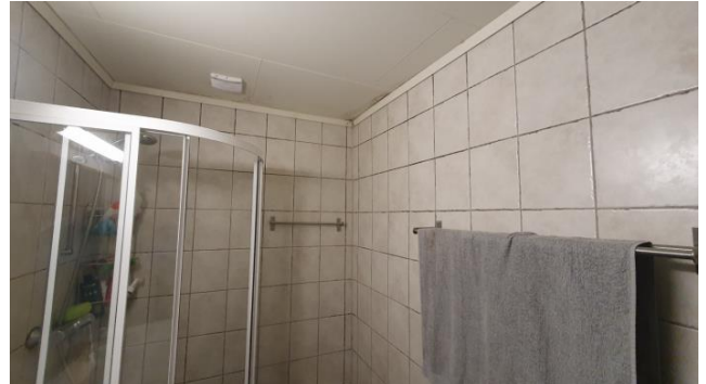
Defekt avtrekksvifte, muggdannelse i tak.
